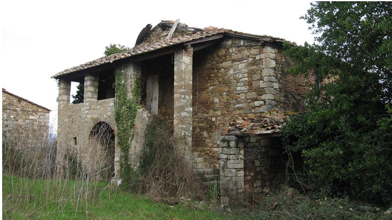
Foto di edificio esistente nel borgo di Elci, estrapolata dalla schedatura del Patrimonio Edilizio Esistente del RU di Radicondoli
